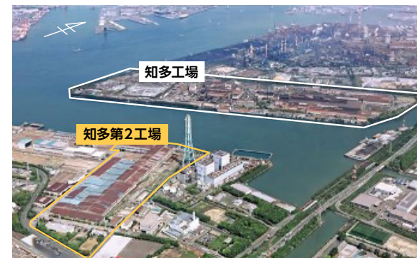
知多第2工場（2025年度開始） 半導体製造装置向け高純度ステンレス鋼をはじめとする成長市場製品の製造拠点
