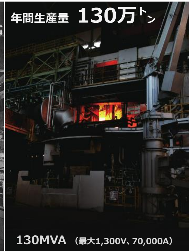
150ト、電氣アーク炉 大同特殊鋼 知多工場
